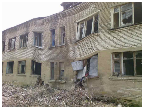
Рис. 1. Примеры последствий изменения несущей способности грунта под частью здания и сооружения
