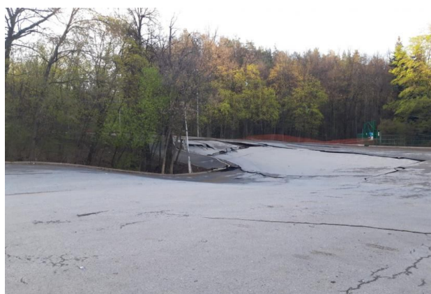
Рис. 1. Примеры последствий изменения несущей способности грунта под частью здания и сооружения
