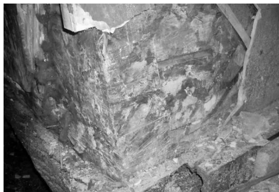
Рис. 4. Внутренняя стена Храма выполнена из бруса, отшпаклёвана, окрашена, затем оштукатурена по слою овечьей шерсти и драни. Видны следы окраски
