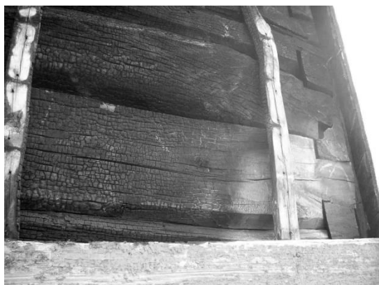
Рис. 5. Сруб барабана. Конструкция дощатой обшивки
