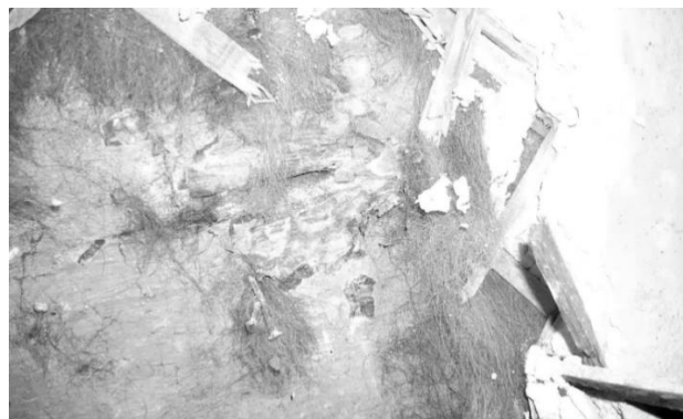
Рис. 4. Внутренняя стена Храма выполнена из бруса, отшпаклёвана, окрашена, затем оштукатурена по слою овечьей шерсти и драни. Видны следы окраски
