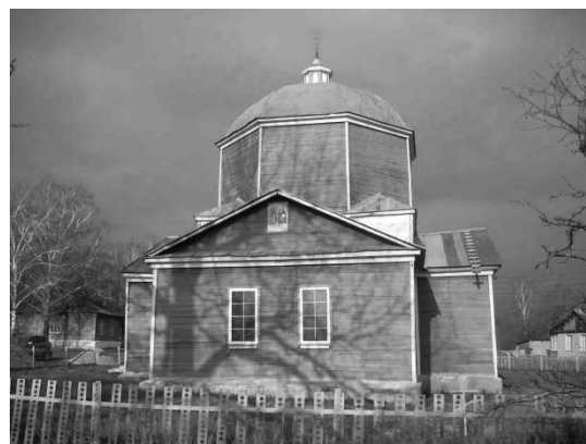
Рис. 6. На отметках от 3,700 до 5,700 стены снаружи обшиты оцинкованным железом
