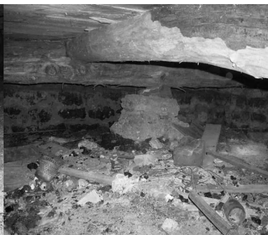
Рис. 9. В некоторых местах лаги опираются на столбики из фосфоритового камня
