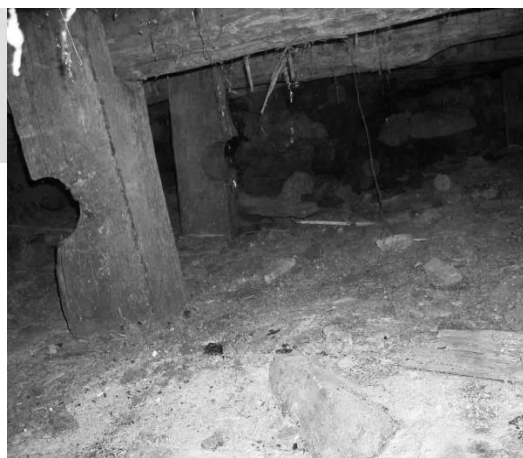
Рис. 8. На участках между осями лаги опираются на дубовые стулья
