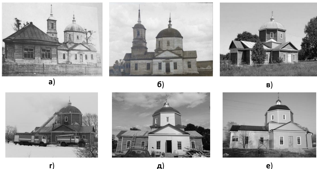
Рис. 1. а – наиболее старая из найденных фотографий Храма, датируемая предположительно 1940-е – до 1952 г.; б – изображение храма, предположительно 1950 – 1960 гг.; в – здание до пожара зимой 2013 г.; г – пожар здания в 2013 г.; д – ремонт здания в 2015 г. На одной части здания сохранилась деревянная дощатая обшивка, другая отделана пластиковым сайдингом; е – здание после ремонта. Фасад отделан пластиковым сайдингом серого цвета, маковка храма заменена
