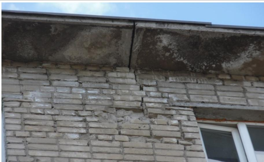
**Рис.3.** Замачивание железобетонных плит, выветривание цементно-песчаного раствора, разрушение лицевой стороны кирпичной кладки на толщину менее 15 % толщины
