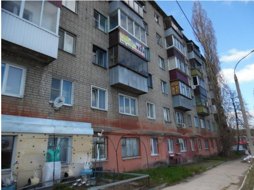
**Рис.1.** Замачивание и частичное разрушение штукатурного слоя цокольной части здания
