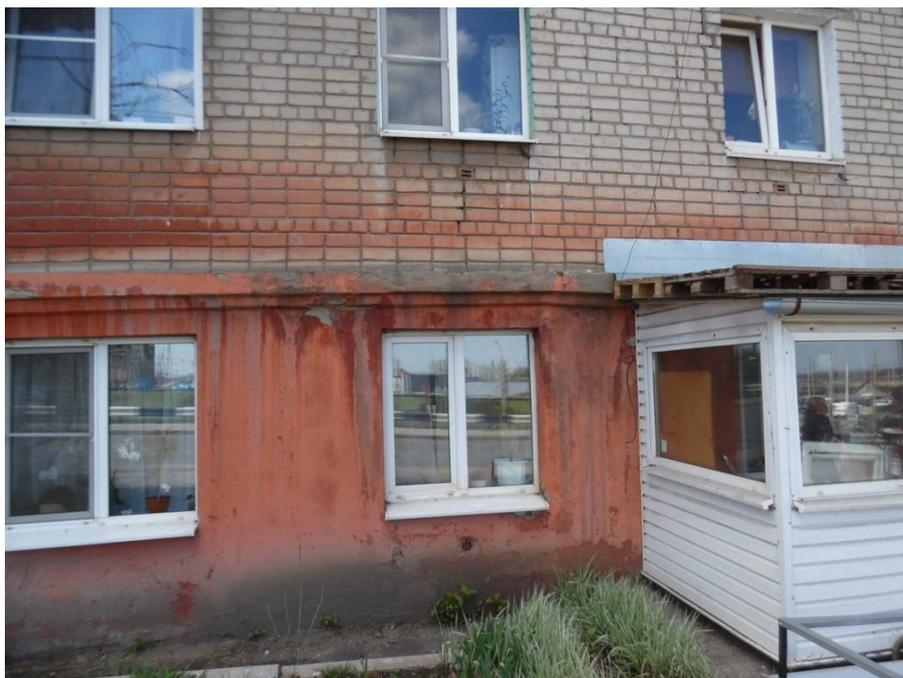
**Рис.2.** Замачивание и частичное разрушение штукатурного слоя цокольной части здания.
