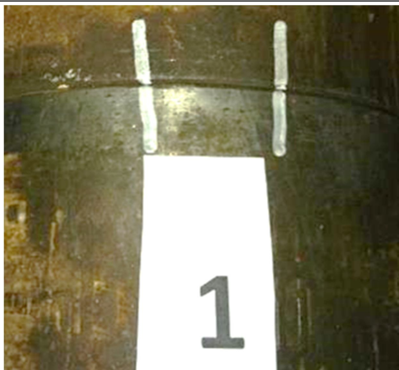
Рис. 4. Метки, нанесенные на свинченные в первый раз трубы
