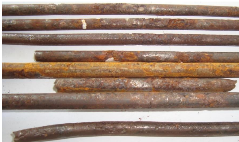
Рис. 2. Вид коррозионных повреждений на поверхностях стержней
