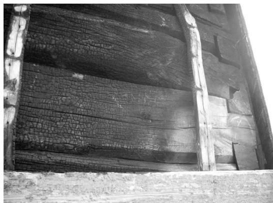
**Рис. 5.** Сруб барабана. Конструкция дощатой обшивки
