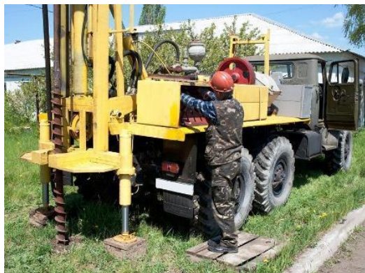
Рис. 4. Буровая установка УРБ 2А2
