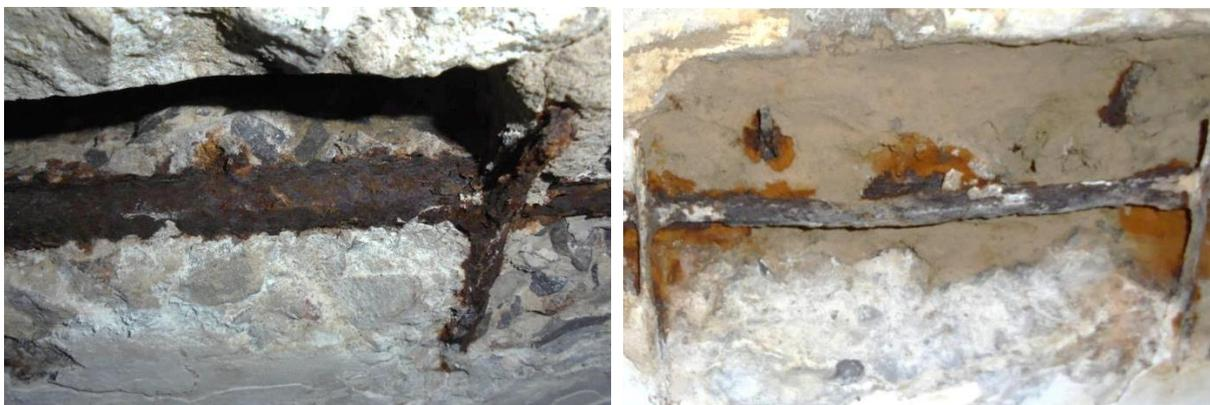
Рис. 3. Состояние узлов опирания межколонных и пролетных плит перекрытия на колонные плиты, сопровождающиеся разрушением опорных участков (консолей, зуба) и значительной коррозией арматуры
