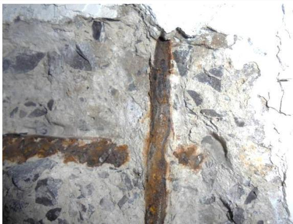
Рис. 2. Значительная коррозия продольной и поперечной арматуры на вскрытом участке межколонной плиты перекрытия
