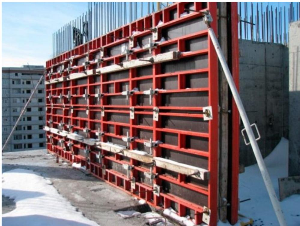
**Рис. 1.** Пример применения съемной опалубки при возведении монолитно-бетонной вертикальной стены
