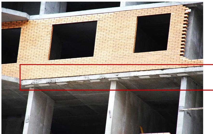
Рис. 1. Термовкладыши в монолитном перекрытии
